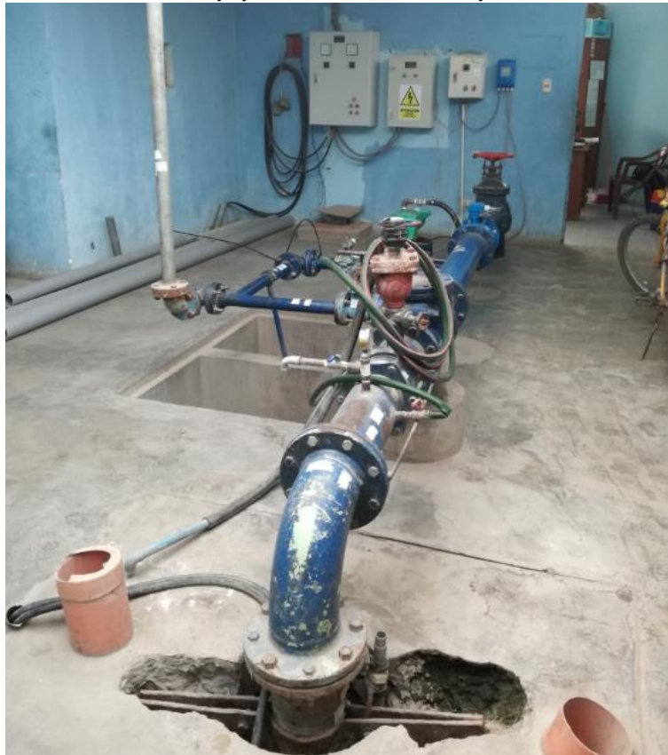
Imagen N° 37: Vista del equipo de bombeo de la Captación Pozo Los Aquijes
