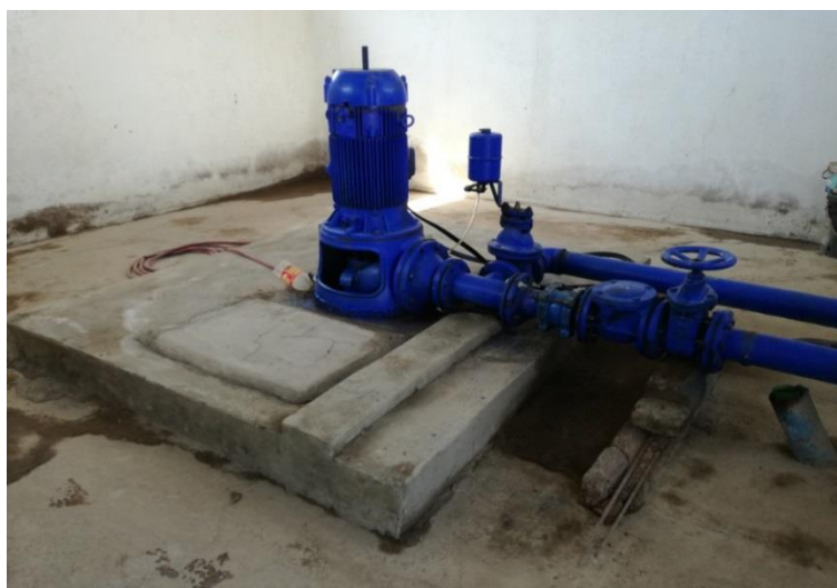
Imagen N° 30: Vista del equipo de bombeo de la Captación Pozo N°2
