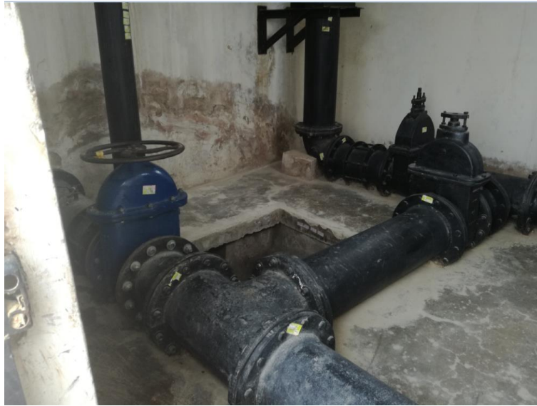
Imagen N° 20: Vista interna del reservorio elevado de 1000m 3
