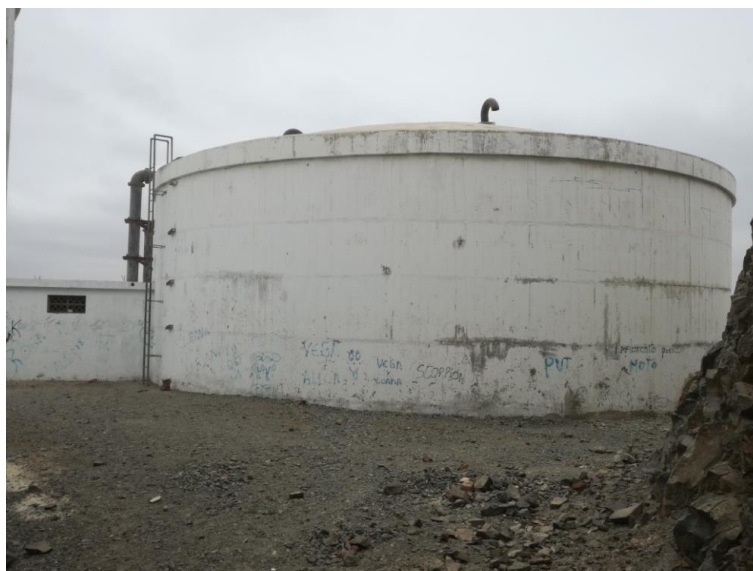
Imagen N° 19: Vista externa del reservorio apoyado de 1500m 3
