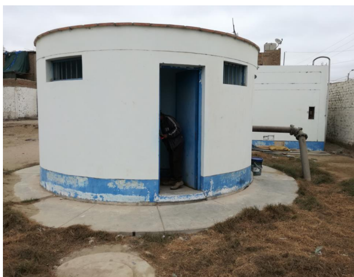
Imagen N° 45: Vista externa de la Cámara de bombeo de desagüe “El Arenal”
