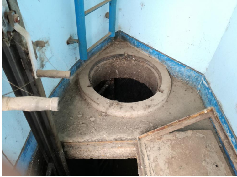
Imagen N° 46: Vista interna de la Cámara de bombeo de desagüe “El Arenal”
