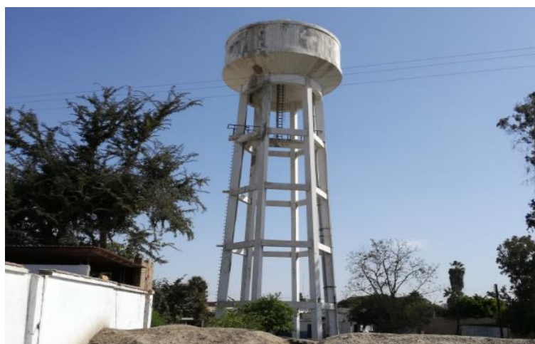
Imagen N° 31: Vista del reservorio elevado de 250m3
