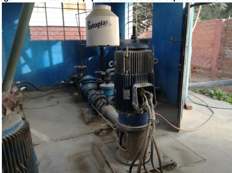
Imagen N° 17: Vista del equipo de bombeo de la Captación Pozo N°2
