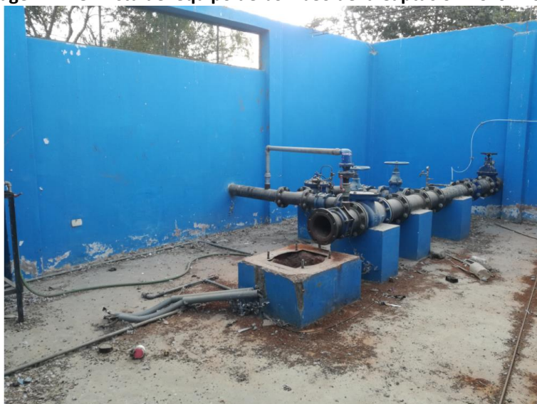
Imagen N° 18: Vista del equipo de bombeo de la Captación Pozo N°3
