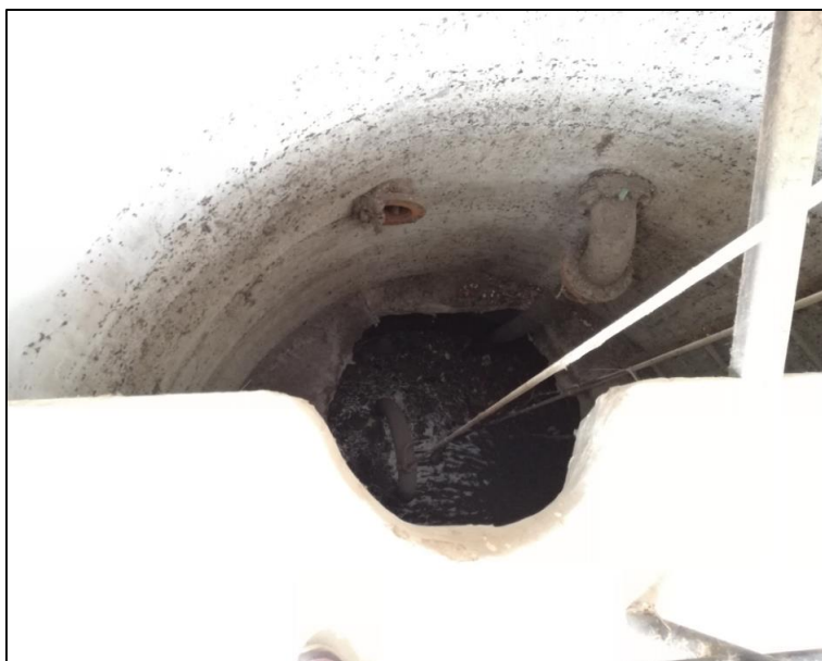
Imagen N° 44: Vista interna de la Cámara de bombeo de desagüe “Los Yupanquis”
