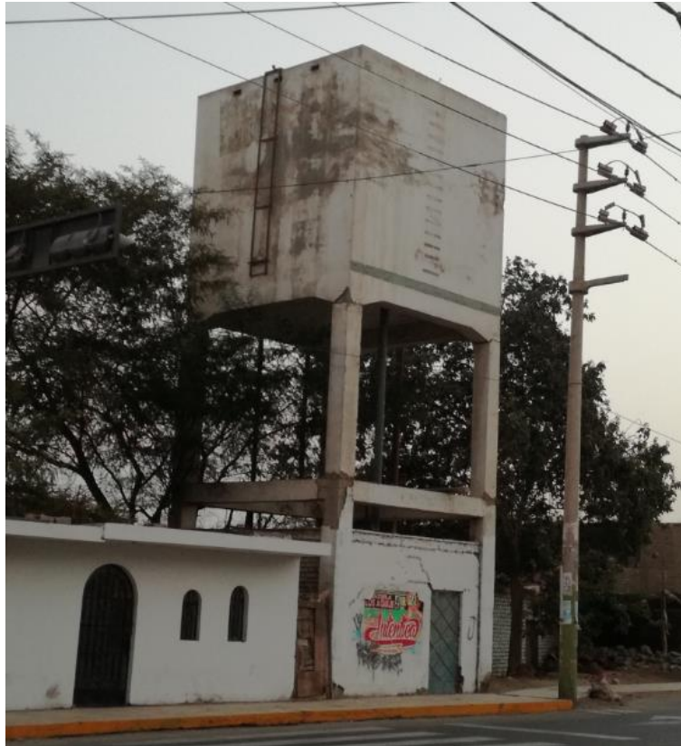
Imagen N° 38: Vista del reservorio elevado de 60m3
