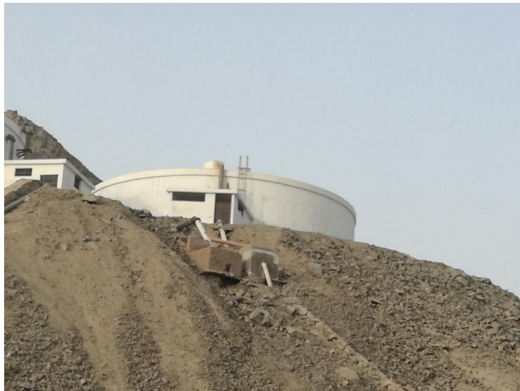
Imagen N° 21: Vista externa del reservorio inoperativo de 1200m 3
