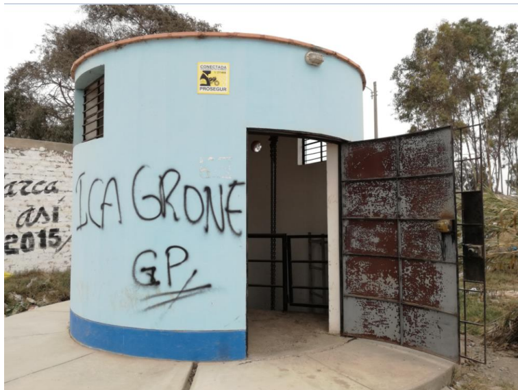
Imagen N° 47: Vista externa de la Cámara de bombeo de desagüe “Garganto”
