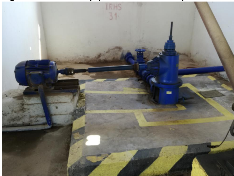
Imagen N° 29: Vista del equipo de bombeo de la Captación Pozo N°1
