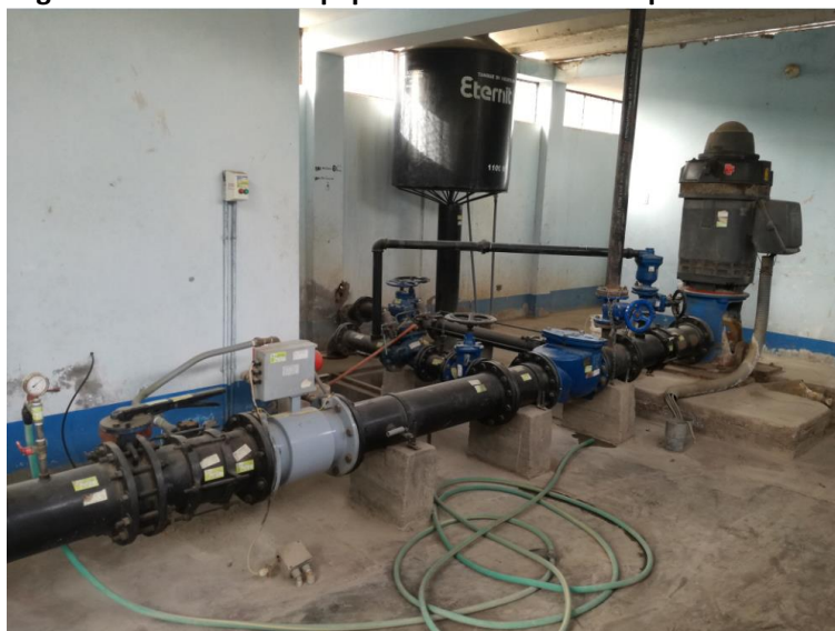
Imagen N° 16: Vista del equipo de bombeo de la Captación Pozo N°1
