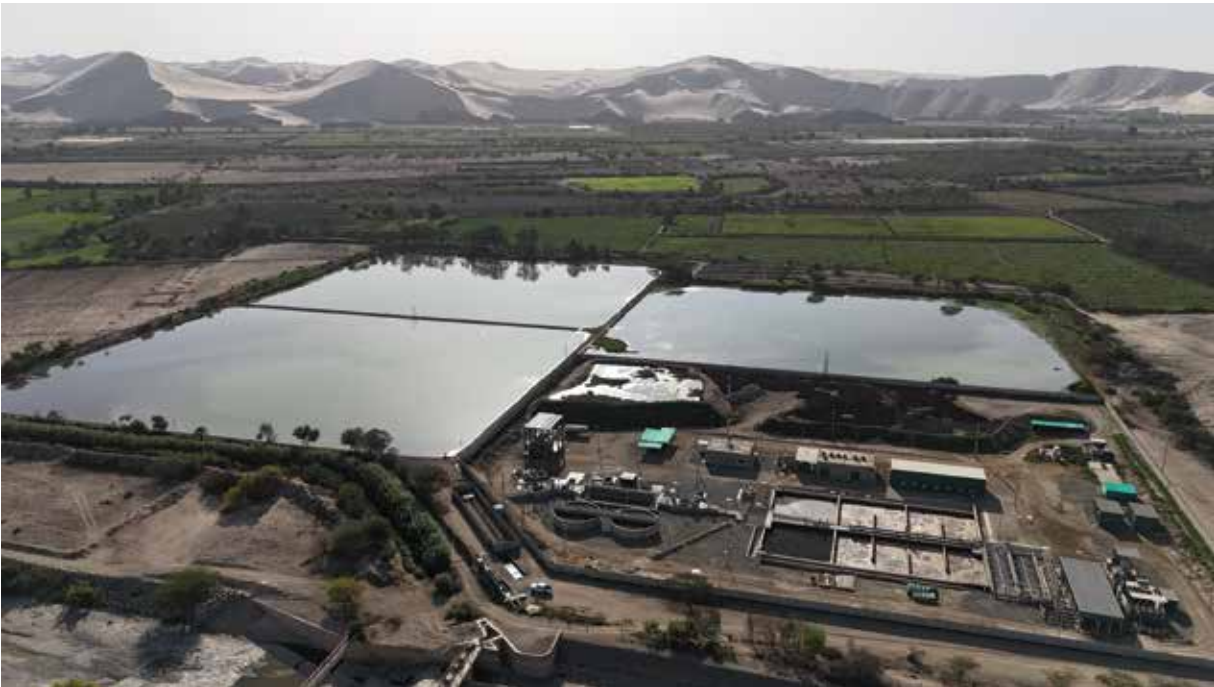
PTAR Agroka y PTAR Cahiche - Octubre del 2024
