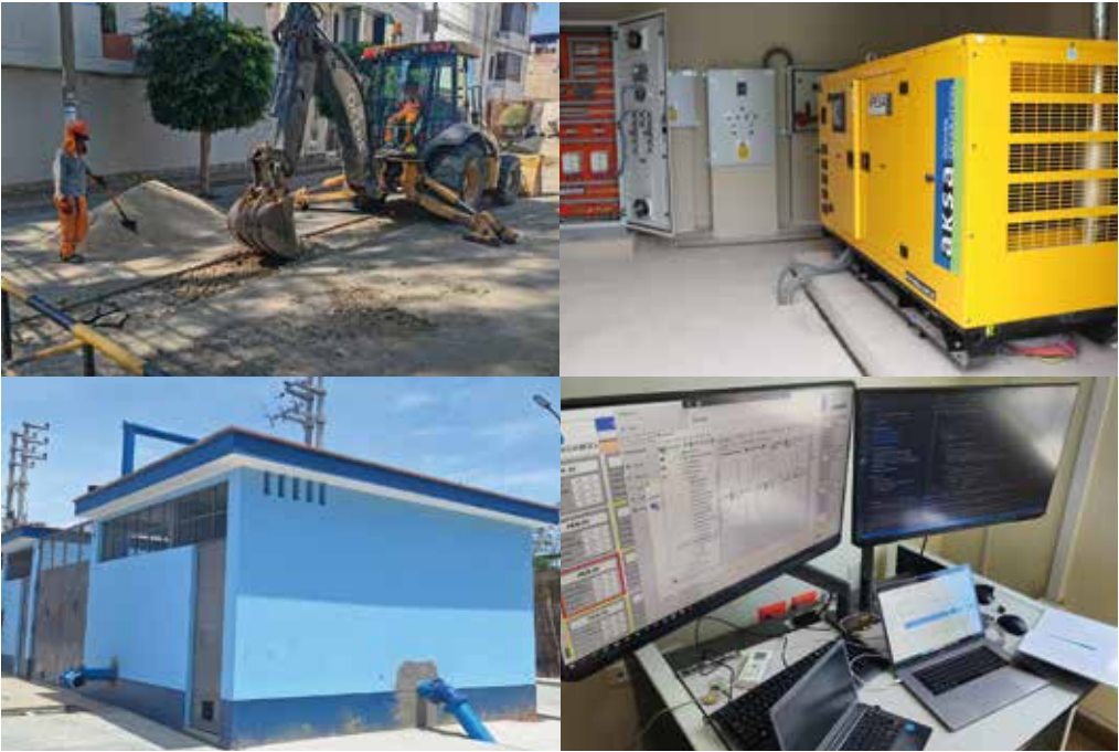
Fotografías N° 01: Obras y proyectos ejecutados en el año 2025.
