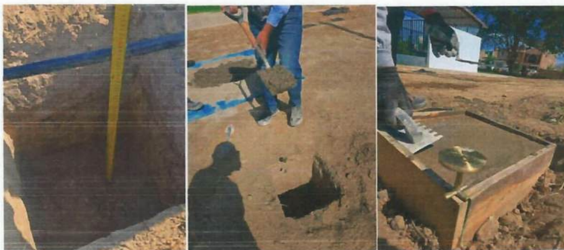
Figura 11: Monumentación tipo hito de concreto enterrado.
