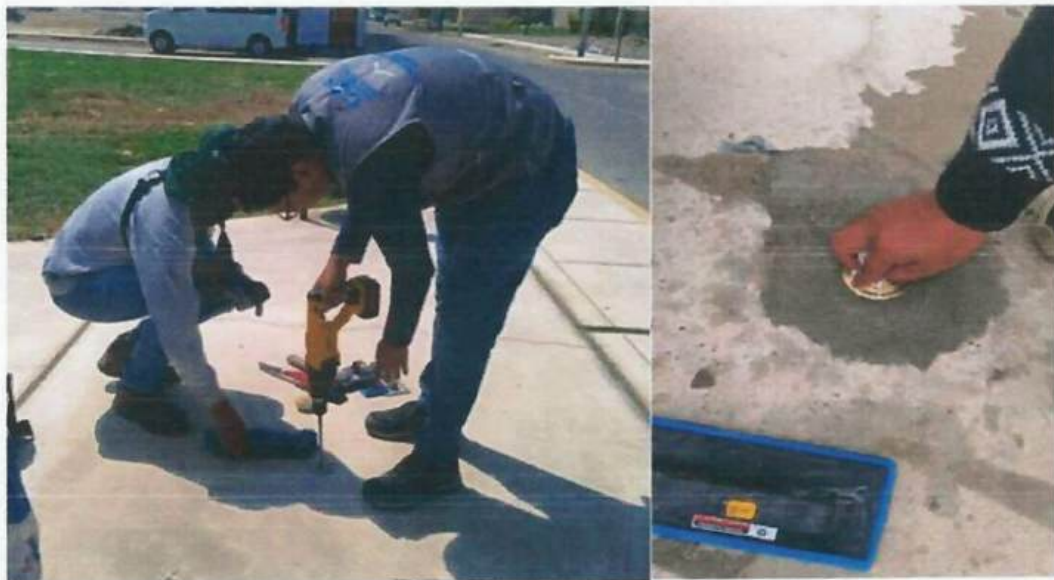
Figura 9: Monumentación de hito mediante la incrustación en veredas
